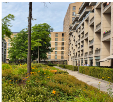
De binnentuin biedt een voldoende dik dakpakket voor een gevarieerde beplanting
