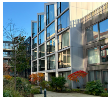
Het gevelbeeld aan de dwarsstraten is divers
