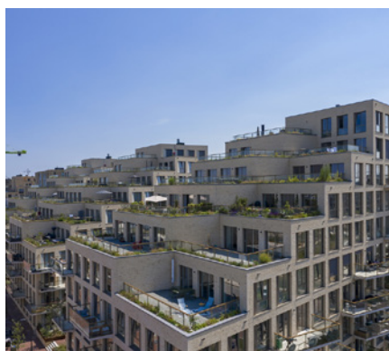
Aandacht voor bezonning en windhinder © Arons en Gelauff architecten, Foto: Luuk Kramer
