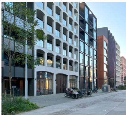
De blokken in Entree zijn stedelijk met wisselende korrel en met verschillen in ritmiek, geleding en detaillering
