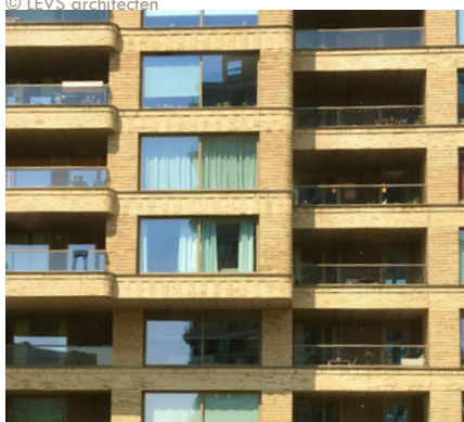
Geluidwerende maatregel dmv balkons met absorberend plafond en gesloten borstwering
