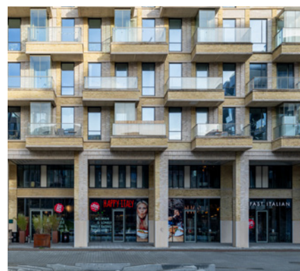
Plint in de sokkel met levendig programma over twee bouwlagen
